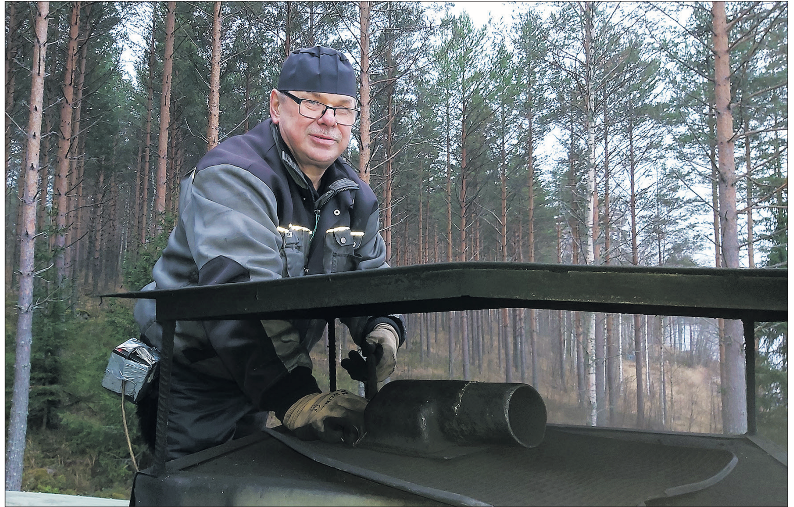
Kalevi Kodratjeff laitto savupiipun suulle alipaineistajan, jotta noki ei päädy sisätiloihin.
